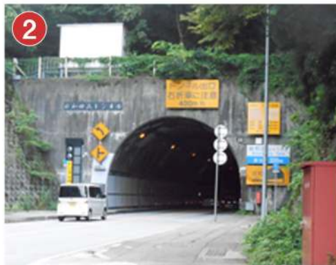
② 新和田山トンネル
